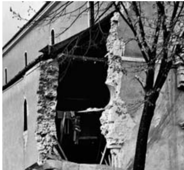
Bombardiranjem oštećena samostanska crkva u Mostaru
