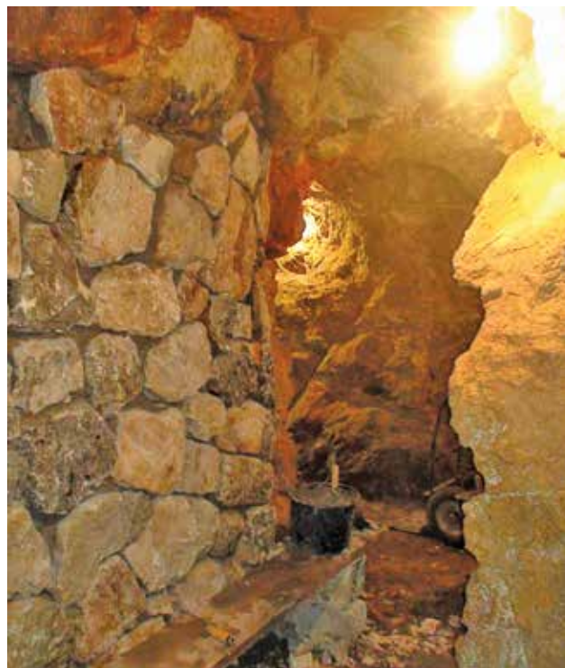
Dovršavanje potpornog zida u unutrašnjosti ratnog skloništa
