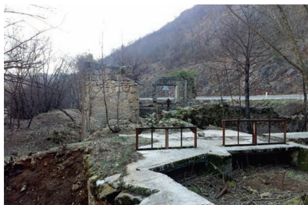
Današnji izgled mlinice i hidrocentrale nakon čišćenja
