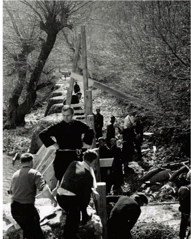
Fra Andrija Jelčić nadgleda rad na kanalu za hidrocentralu
